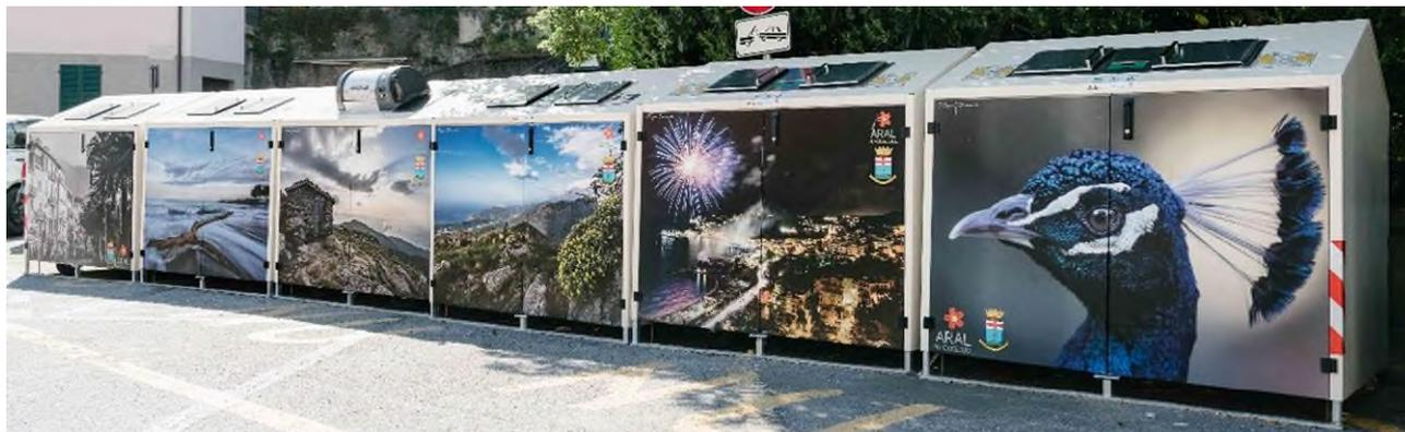
Ciascun modulo di raccolta sarà realizzato in scatolato (in lamiera zincata o materiale plastico) di spessore adeguato, assemblato mediante viti e bulloni e con tubolare di rinforzo per garantirne la stabilità, chiuso con coperchio a due falde, con falda posteriore fissa e falda anteriore apribile, con maniglia per l'apertura e gancio per la chiusura che copre anteriormente il bordo delle ante per impedire l'infiltrazione della pioggia.
